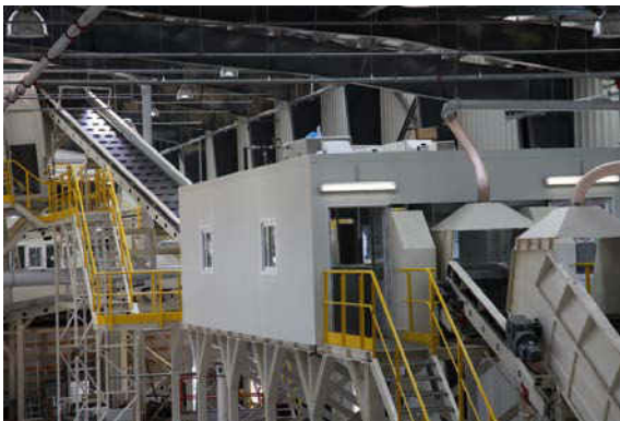
Εικόνα 3. Εσωτερικό εγκατάστασης ΚΔΑΥ Κρωπίας της
