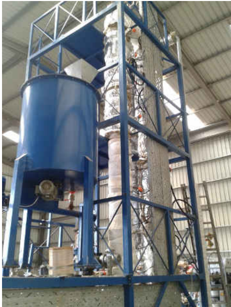
Εικόνα 5. Ανέγερση μονάδας αεριοποίησης
