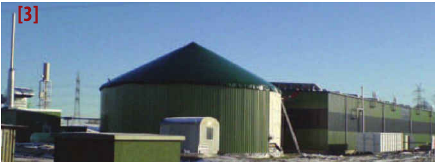
Μονάδα αναερόβιας επεξεργασίας ζωικών αποβλήτων
